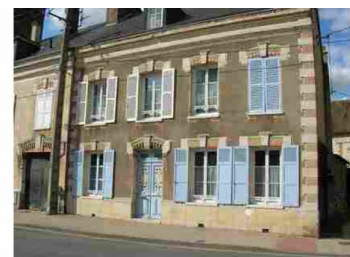
chaînage pierre/brique + enduit
