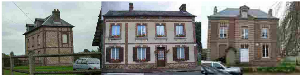
chaînage brique + pierre
